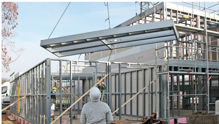
Einbau eines Zwischendeckenelements
